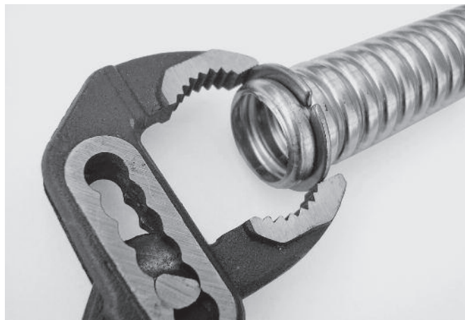
Fig. 4 Mise en place de la bague de serrage
