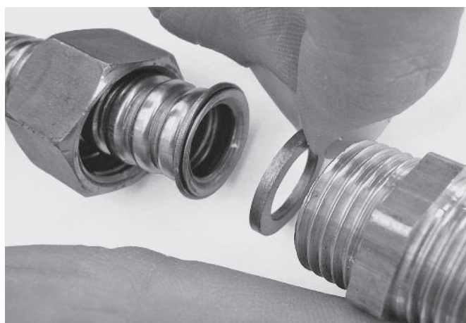
Fig. 6 Collocare la guarnizione in rame tra estremità e raccordo
